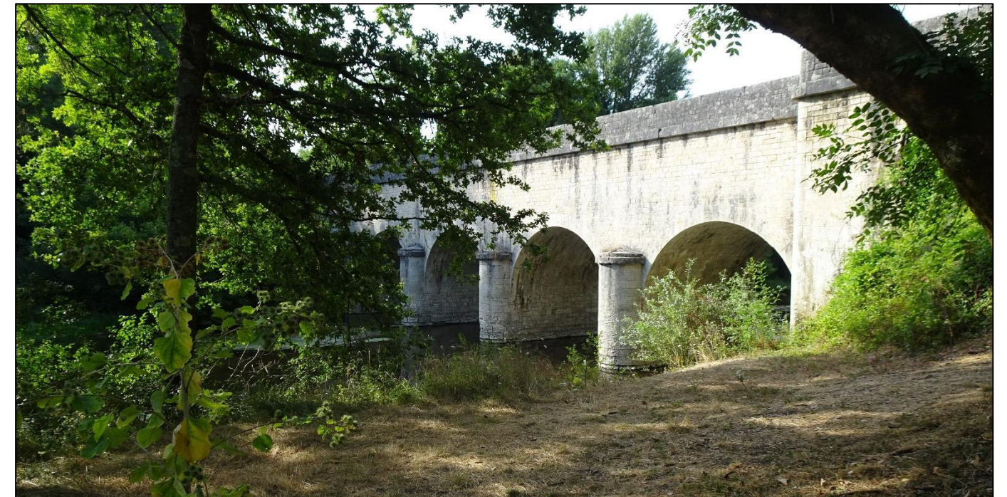
Figure 141 : Prise de vue 1 - photographie du Pont canal (Crédit photo : NCA Environnement)
