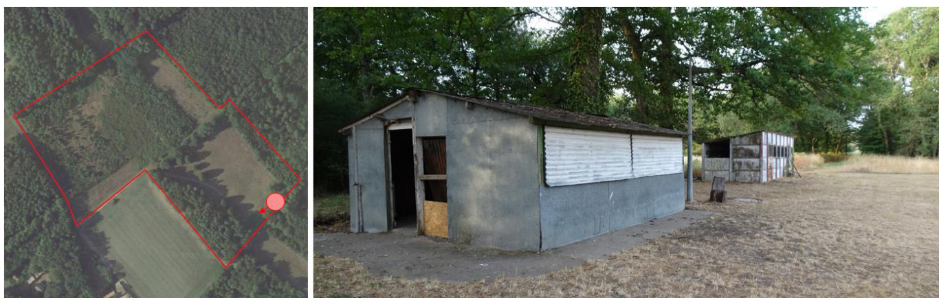
Figure 186 : Photographie des anciens vestiaires présents sur l'ancien stade de football (Crédit photo : NCA Environnement)
