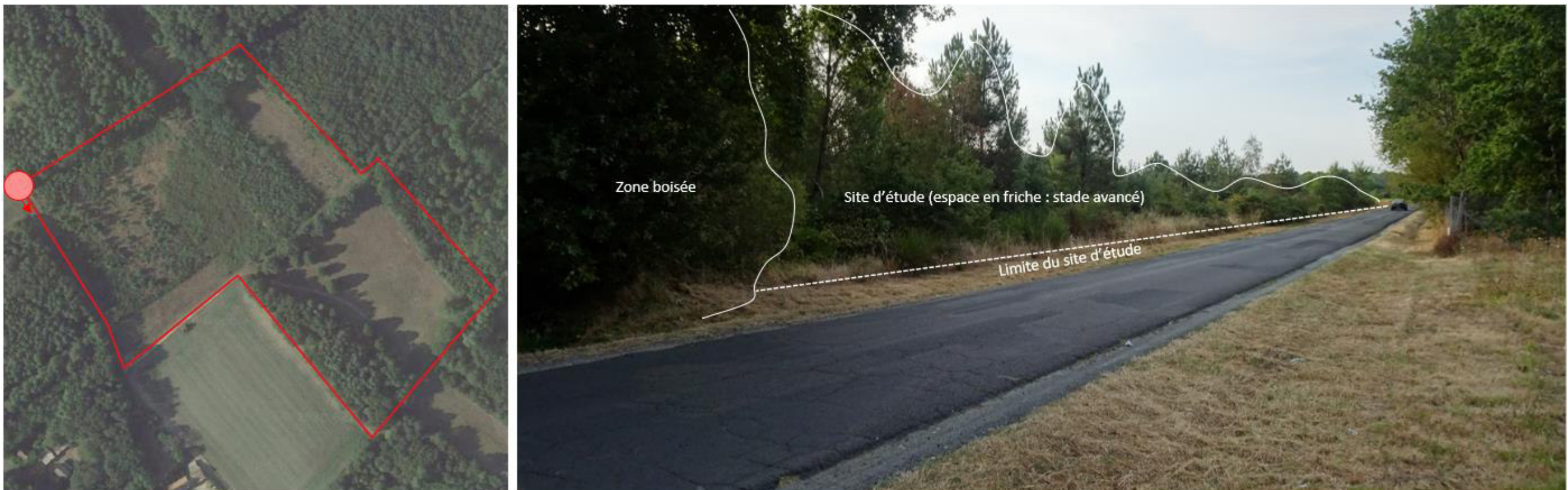
Figure 190 : Photographie de la limite ouest du site d'étude - la départementale et la zone boisée présente à gauche du cliché cadrent la zone en friche du site d'étude (Crédit photo : NCA Environnement)
